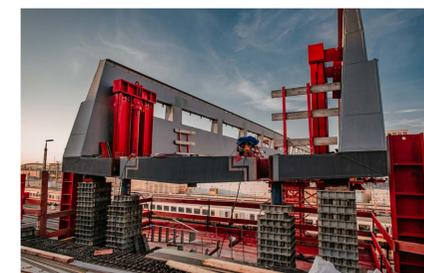
Fertig eingeschobener Überbau in noch überhöhter Lage
