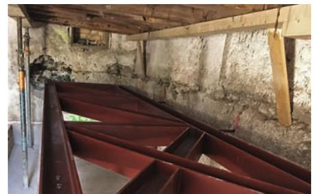
Dieses aufwändige Verfahren ermöglicht, ganze Wände in ihre Ausgangslage zurückzusetzen. In der Mühlgasse 12 wäre die komplette Begradigung aufgrund der porösen Mauerbeschaffenheit allerdings zu riskant gewesen. Es galt also, den Status quo bei höchster Stabilisierung zu sichern.
