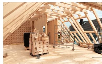
Ein Dachstuhl, gebaut aus Triqbriqs.
