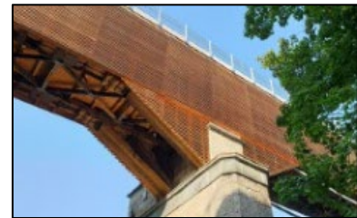
Bildunterschrift: Historische König-Ludwig-Brücke Bild: © Konstruktionsgruppe Bauen AG
