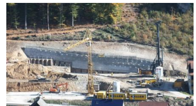
Hotel-Sponsel-Regus, Heiligenstadt, Baugrubensicherung
