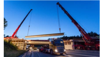
BAB A3, Frankfurt-Nürnberg Teilerneuerung Überführung
