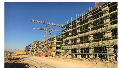
Neubau Bürogebäude, GFK, Nürnberg
