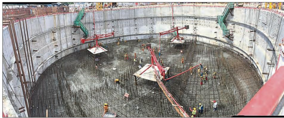
Betonarbeiten im Schacht des Ankerblocks.
