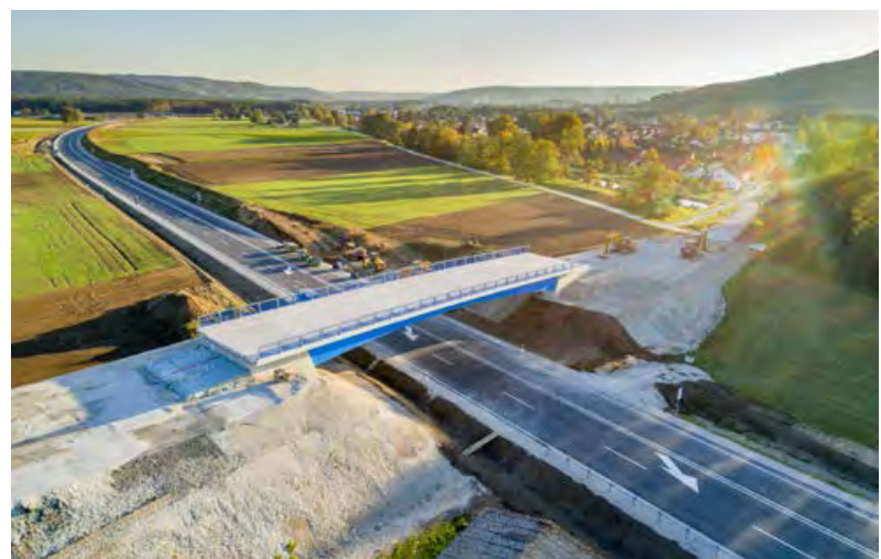
Segmentbrücke Bögl, B299 Mühlhausen
