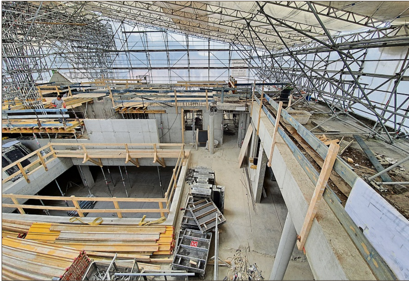
Der Neubau im vierten Obergeschoss unter einem Wetterschutzdach.
