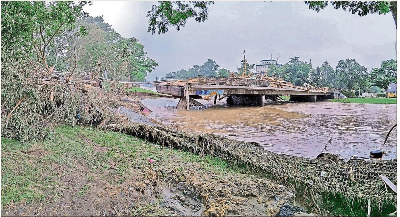
Schaden nach der Überschwemmung: Verklauter Durchflussquerschnitt, der zur Umspülung des südlichen Widerlagers geführt hat.
