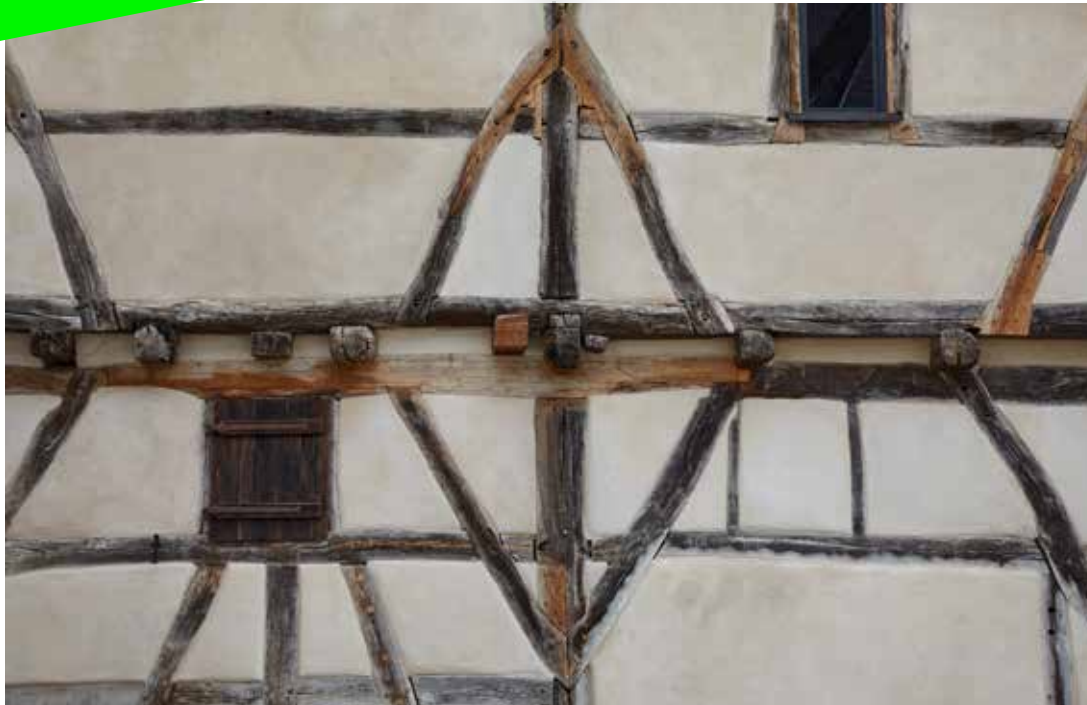
Detail einer Fachwerkfassade in Kirchgaden Thüngersheim
