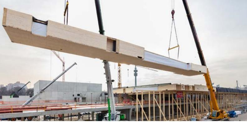
Montage der vorgefertigten 28 m langen und 3,75 m breiten Hohlkastenelemente für das weit auskragende Dach am TUM Campus im Olympiapark.
