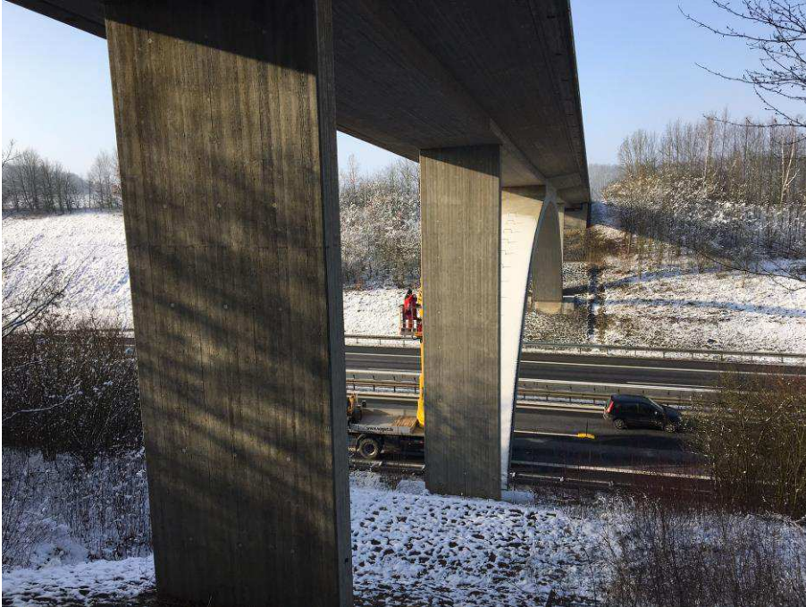
Bauwerksprüfung einer Bogenbrücke, BAB A73
