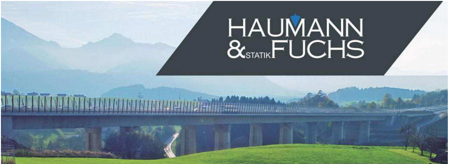
Autobahnbrücke A8 bei Bergen
