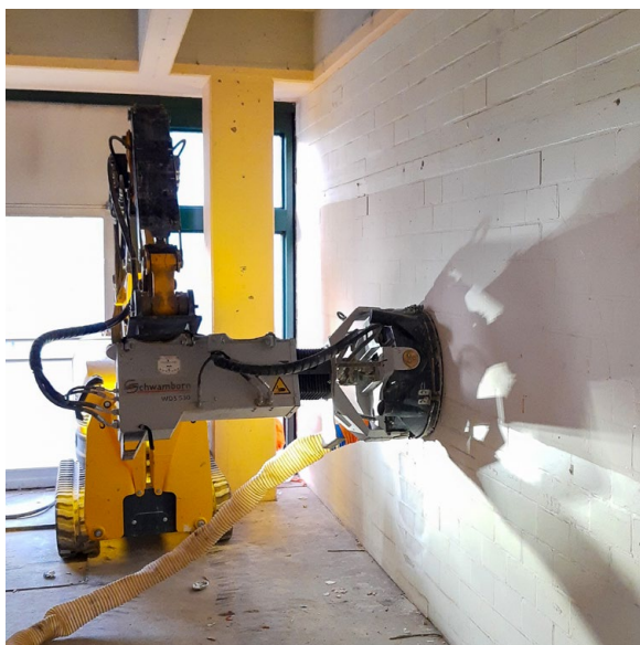
Schadstoffsanierung mit Robotereinsatz
