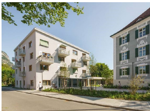
Wohnprojekt „LongLeif GaPa“ mit 24 geförderten Wohnungen für Seniorinnen und Senioren in zentraler Lage von Garmisch-Partenkirchen
