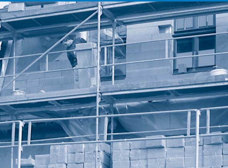
Foto: Bildungszentrum der Handwerkskammer Münster, Gelsenkirchen, Deutschland
