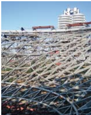
BMW WELT, Stahlkonstruktion in der Bauphase
