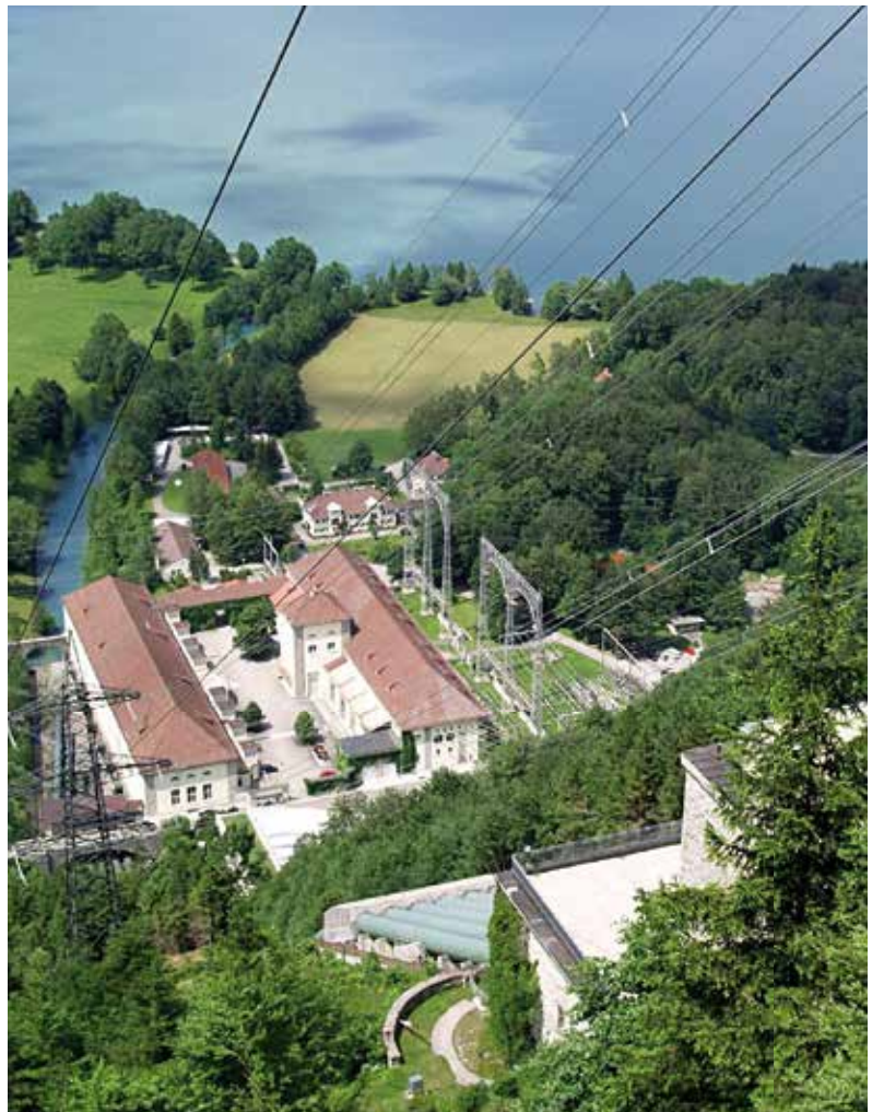
Walchenseekraftwerk Kochel am See, Bayern
