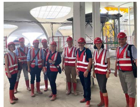
Besichtigung der Baustelle "Stuttgart 21".
