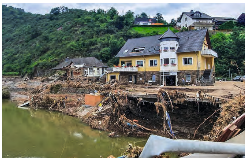
Naturkatastrophen können massive Schäden anrichten
