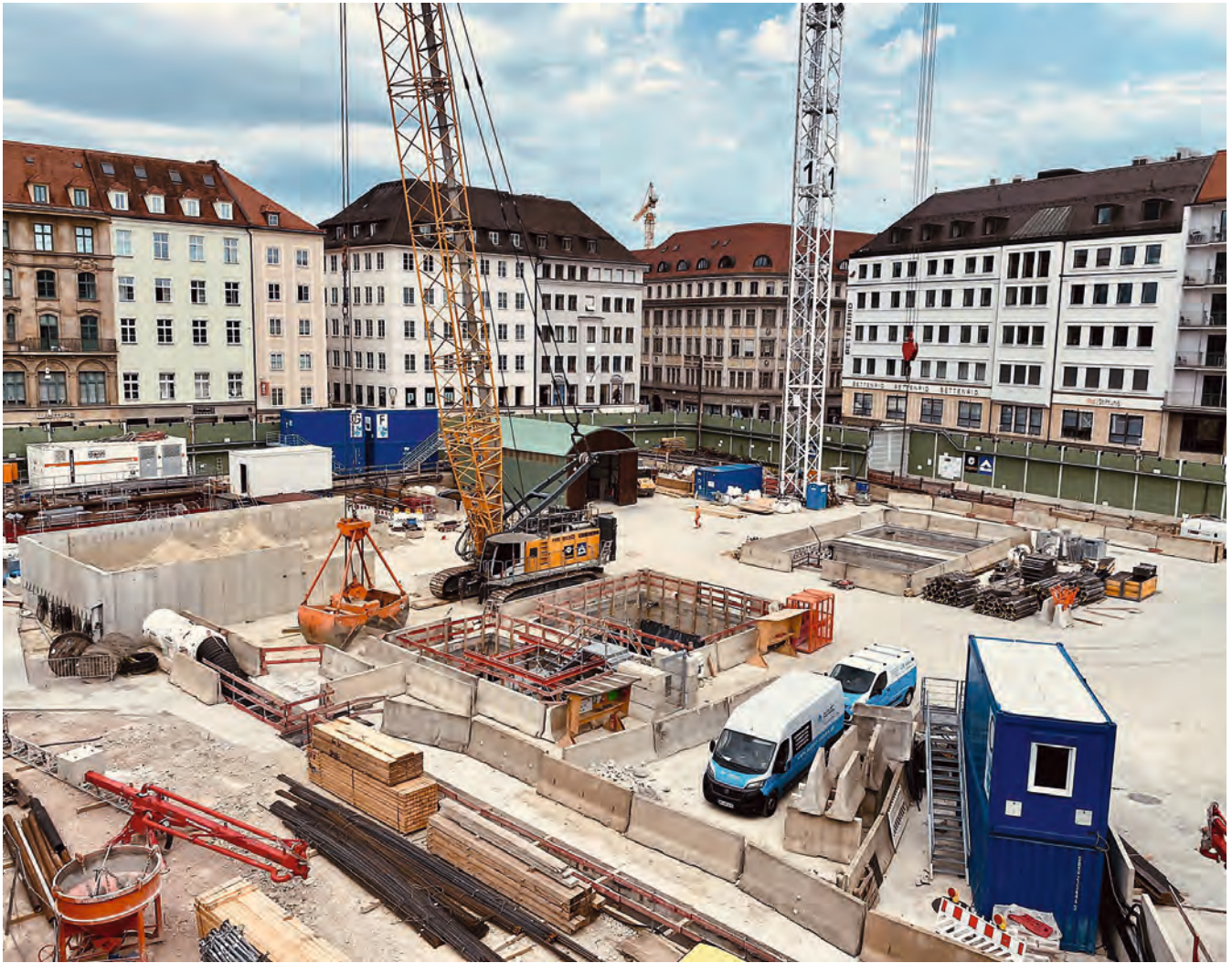
Blick auf die Baustelle der 2. Münchner S-Bahn-Stammstrecke am Marienplatz
