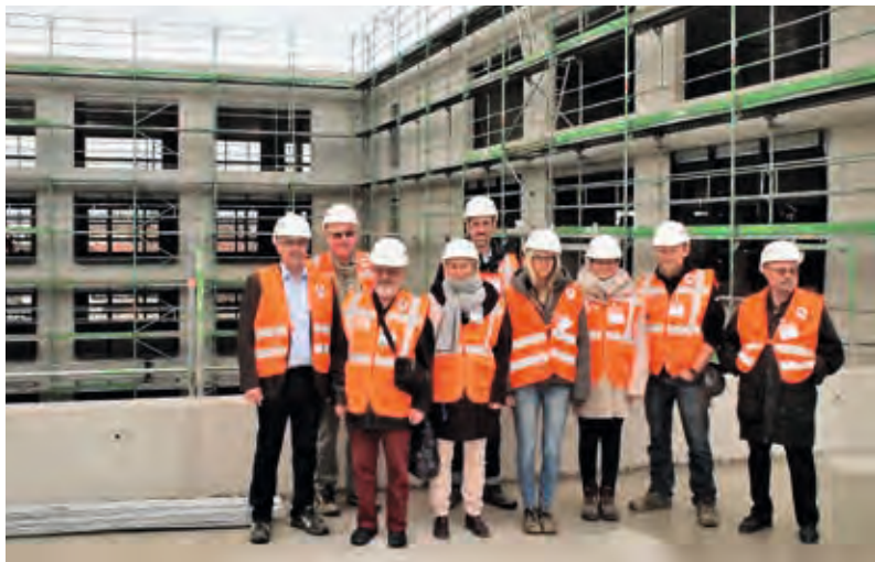
Besichtigung der Großbaustelle GfK-Headquarter
